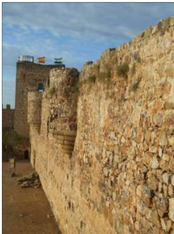
Vista Este del muro diafragma desde el Norte.
