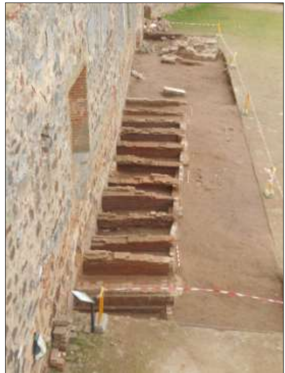
Nivelación de la zona y construcción de nichos en batería.
