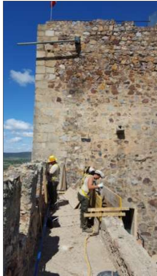
Encofrados con línea de vida para restauración del pretil.
