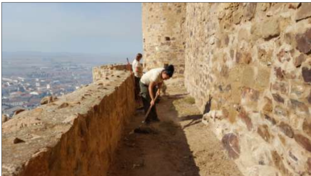
Labores de limpieza y consolidación de lienzos.
