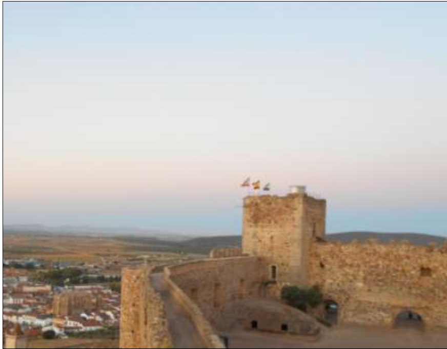
Vista final del pretil o paradós del tramo restaurado.
