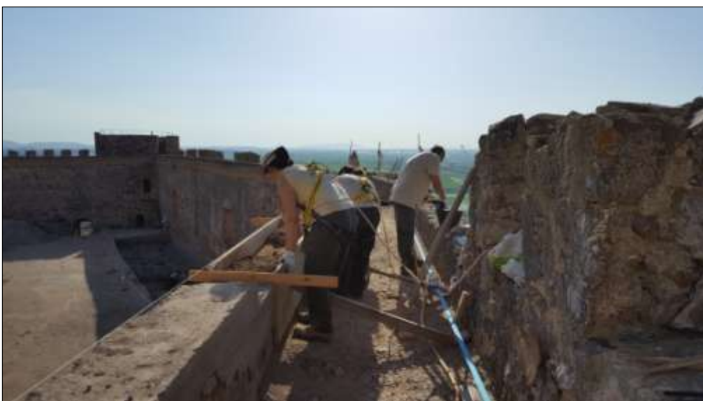
Encofrados para restauración del pretil o parapós.
