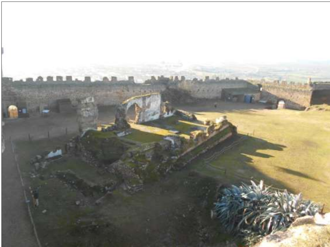
Iglesia de Santa María del Castillo antes de las labores de consolidación.
