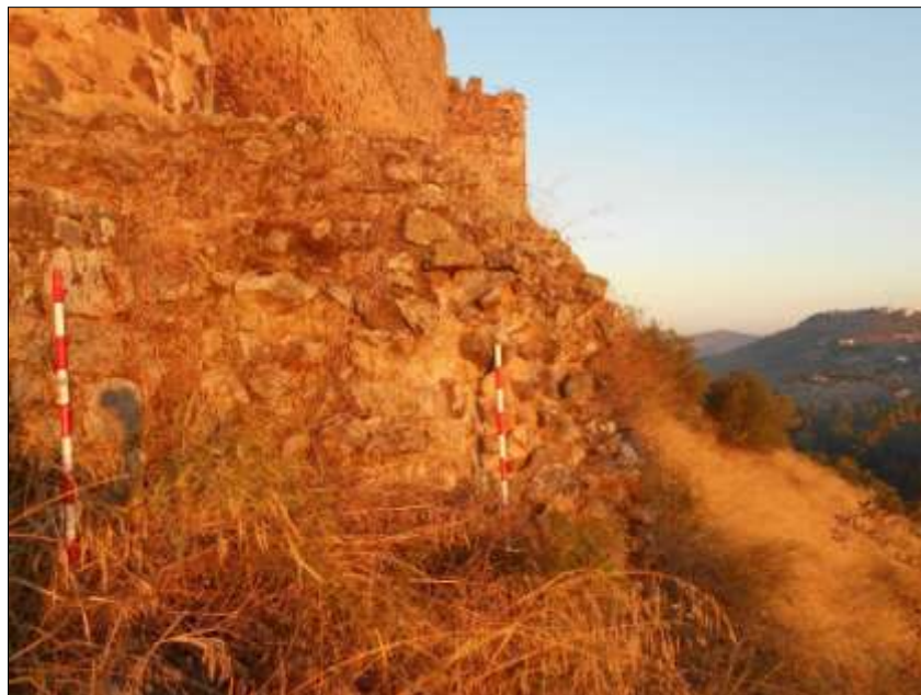
Bloque de opvscaementicvm bajo la torre adosada a la muralla SE.
