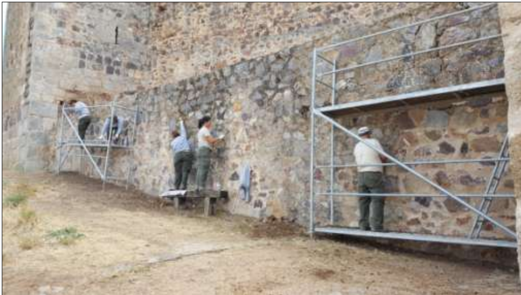
Trabajos de junteado y consolidación del antemural en la zona norte.
