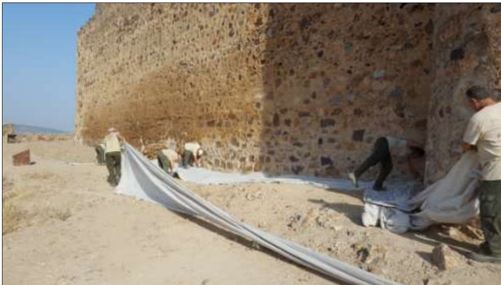
Colocación de malla geotextil en la zona a nivelar.
