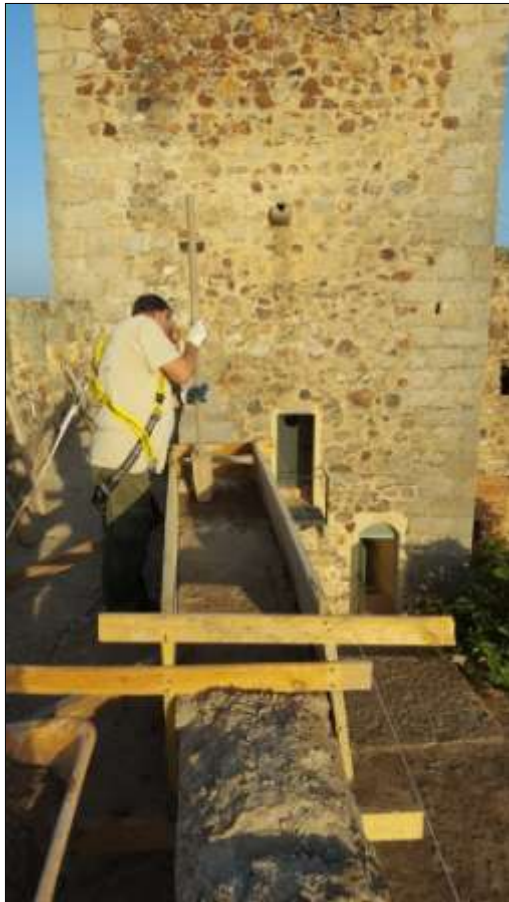
Encofrados con línea de vida para restauración del pretil.
