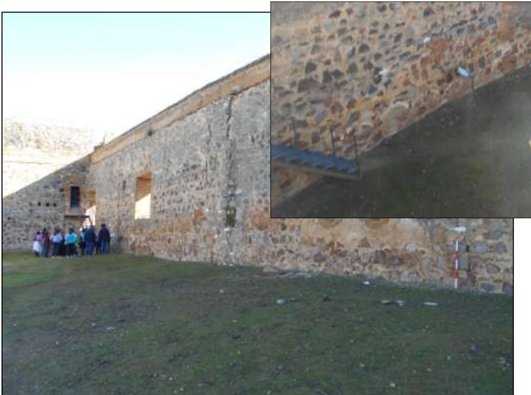
Superficie de inicio del área 1000 y restos de nichos en el lienzo.
