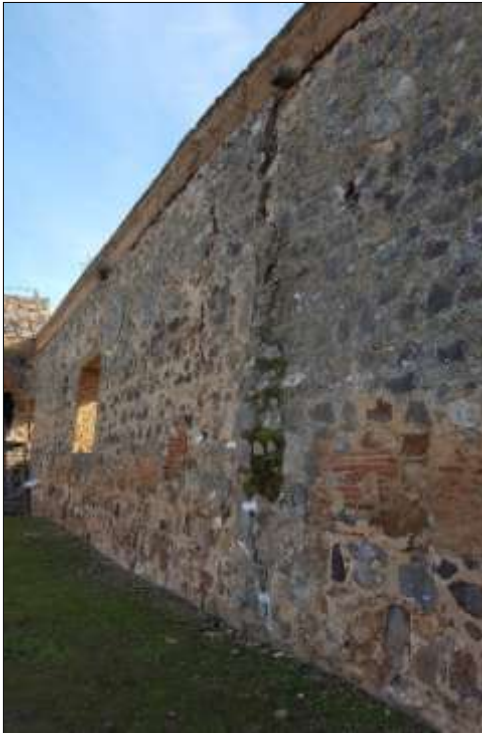
Grieta en la muralla SE y consolidación tras excavación.
